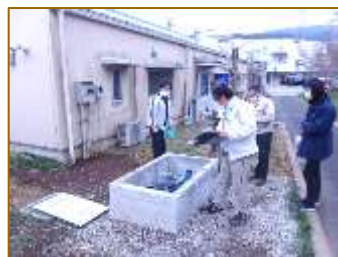
井戸ポンプの設置
